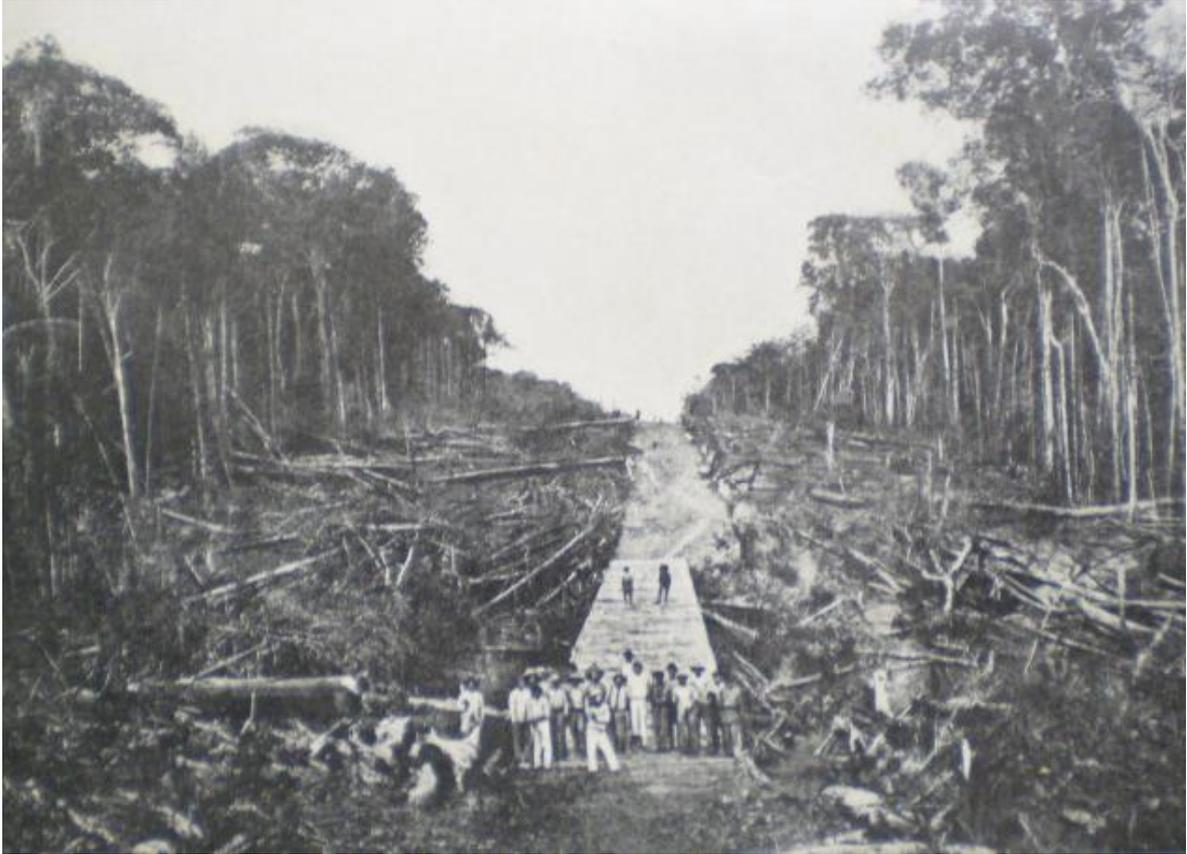
Foto 8 - Trecho do picadão através da mata, vendo-se ao centro a faixa de destocada para a estrada de rodagem – Expedição de 1907 - Relatório apresentado à Diretoria Geral dos Telégrafos e à Divisão de Engenharia do Departamento de Guerra. 2º volume. Construção 1907 a 1910. Acervo Amidicis Diogo Tocantins – UFMT. Reprodução Autorizada
